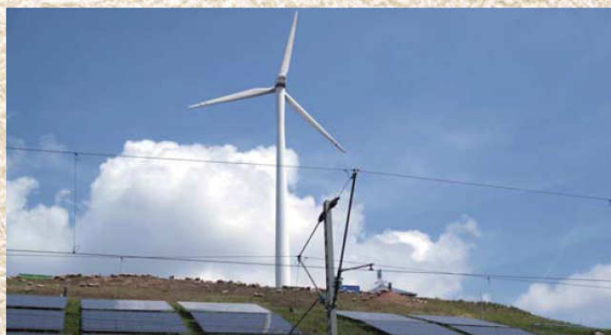
風車1号機(風車の直径52m、最大出力750kW、1999年建設)と、太陽光発電設備(4,000㎡、最大出力432kW、2005年建設)。この丘全体で、約1万人が家庭で使う量の電力を供給している。
