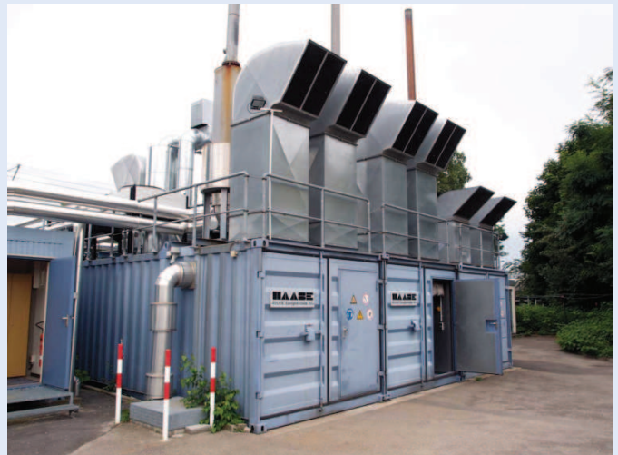
(コジェネレーション施設 = 熱と電力を同時に供給するシステム)
