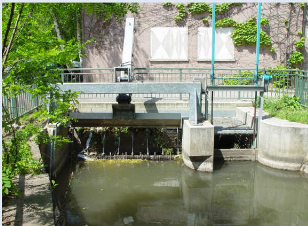
(小水力発電施設の取水口)
